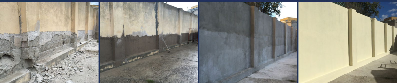
Processo di ristrutturazione muraria esterna
